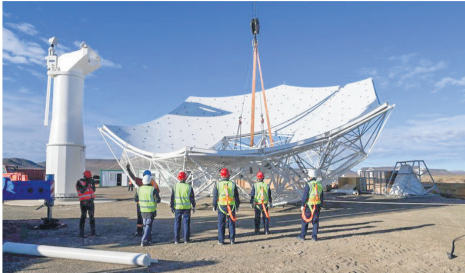
» Reflektor teleskopu SKA-MPG o średnicy 15 metrów tuż przed montażem (pustynia Karoo, RPA). Źródło: South African Radio Astronomy Observatory (SARAO)
