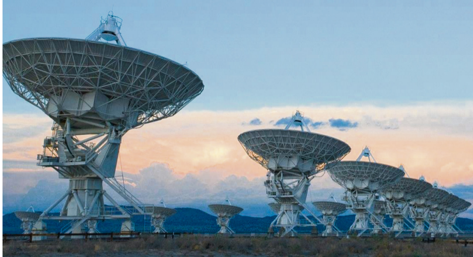
» Very Large Array (VLA) to zbiór 27 radio anten położonych w Socorro, w Nowym Meksyku. Każda z nich ma średnicę 25 metrów i waży 230 ton. Źródło: Alex Savello/NRAO
